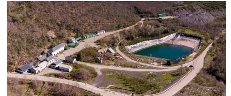
Vista de bocamina e instalaciones asociadas al nivel 3
