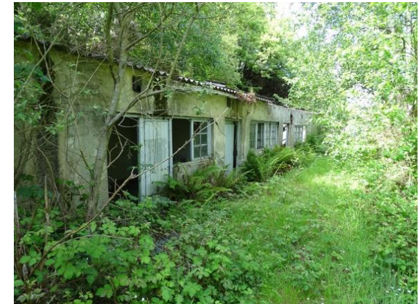
Vista de instalaciones auxiliares
