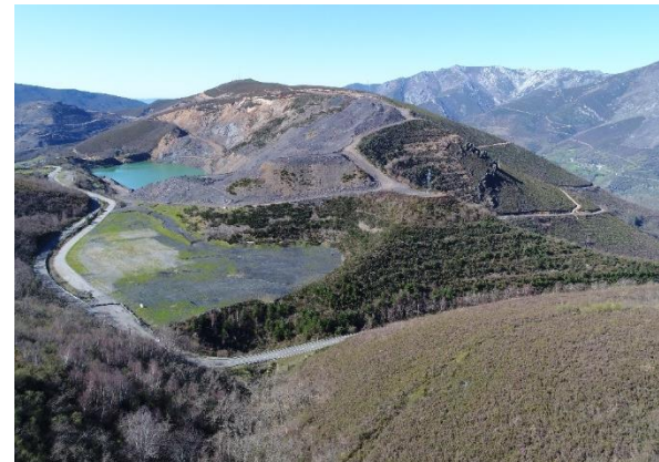
Vista de escombrera del Lago La Campa
