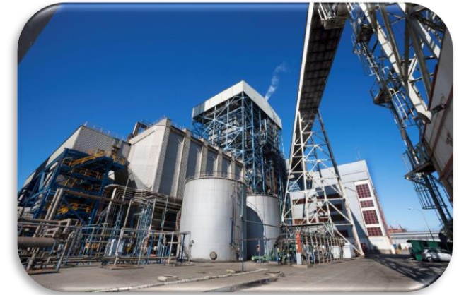
Central de Los Barrios (Cádiz)
