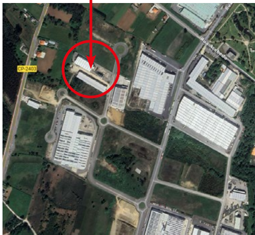
PLANTA DE TRATAMIENTO DE RESIDUOS
