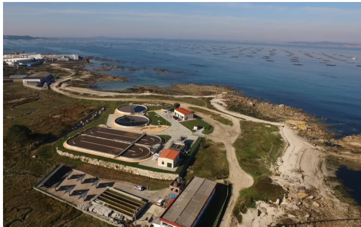
EDAR, colectores y emisario de O Grove (40.000 heq). Construcción y O&M. 2016.
