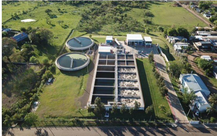
EDAR Ciudad de Artigas, Uruguay (90.000 heq) Construcción y O&M. 2015.
