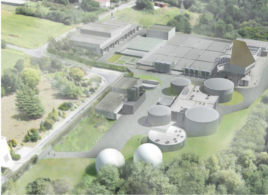
Nueva EDAR de SILVOUTA, Santiago de Compostela (277.000 heq). En ejecución.
