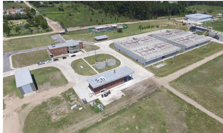
EDAR Ciudad de la Costa, Uruguay (190.000 heq) Construcción y O&M. 2016.
