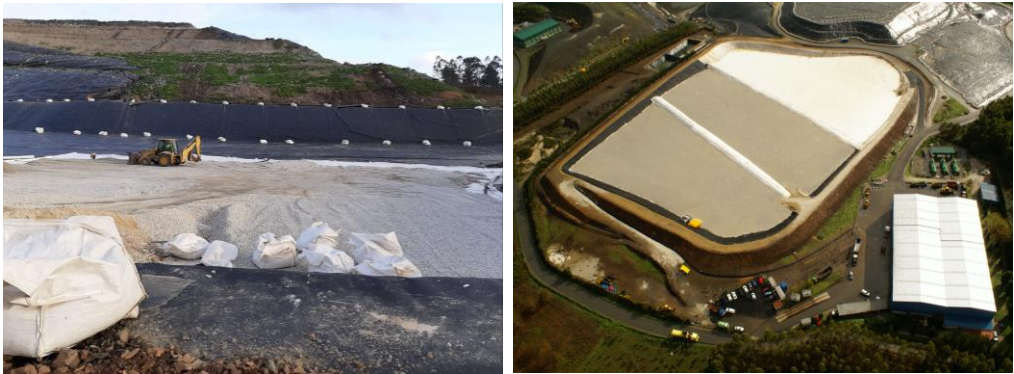
Construcción y O&M de Depósitos Controlados para residuos no valorizables.
