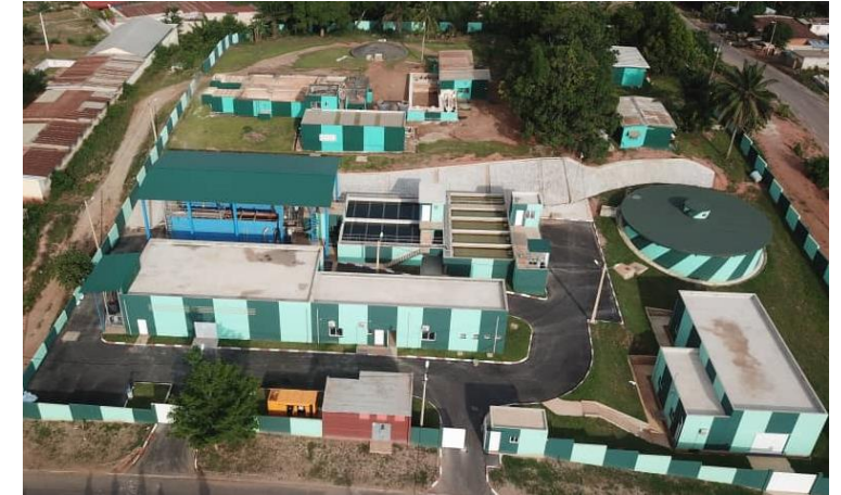
ETAP Ciudad de Agboville, Costa de Marfil (500 m 3 /h). Construcción y O&M. 2016.
