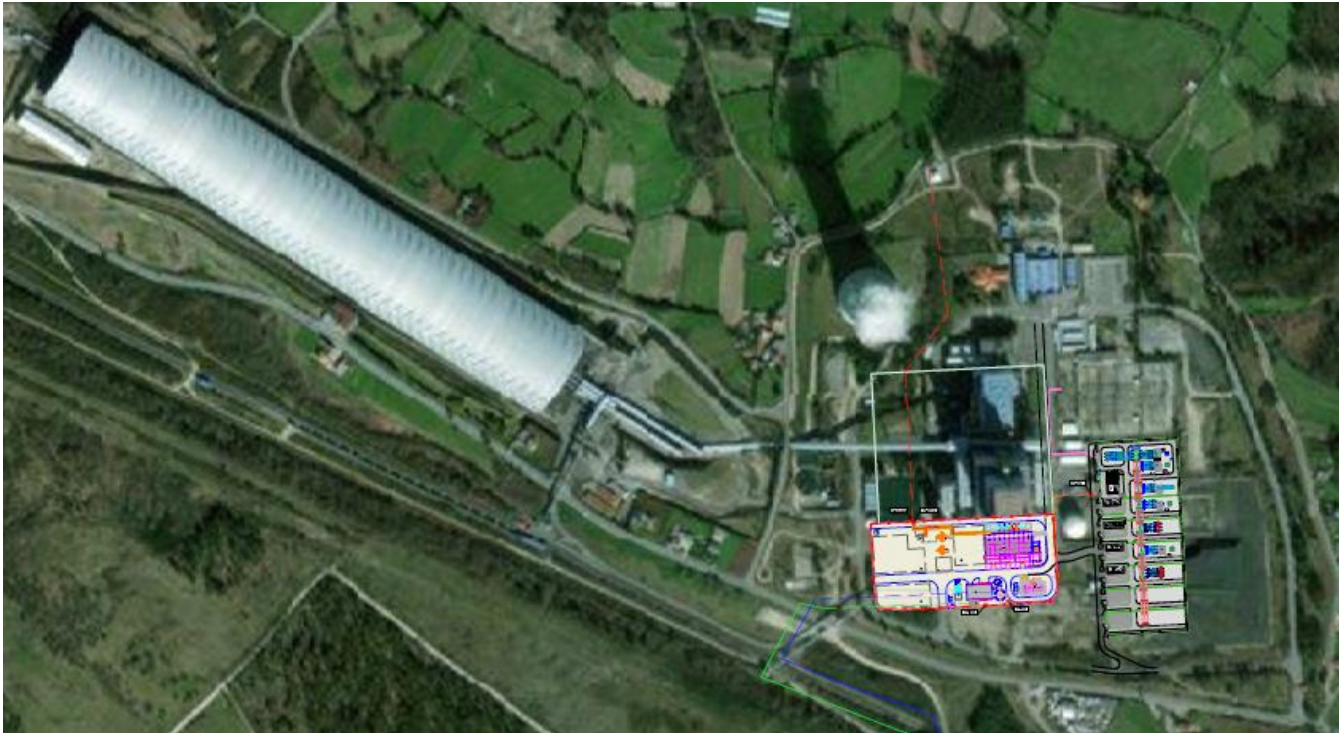
Vista en planta de la planta de electrólisis de 30 MW sobre los terrenos de la central térmica
